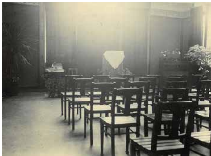
Behelfsmäßig genutzter Gottesdienst- raum im Kurhaus Lahmeyer
