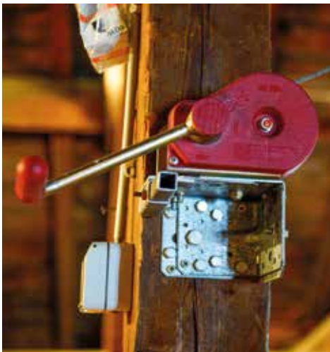
Seilwinde zum Bewegen des Leuchters in der Kirche
